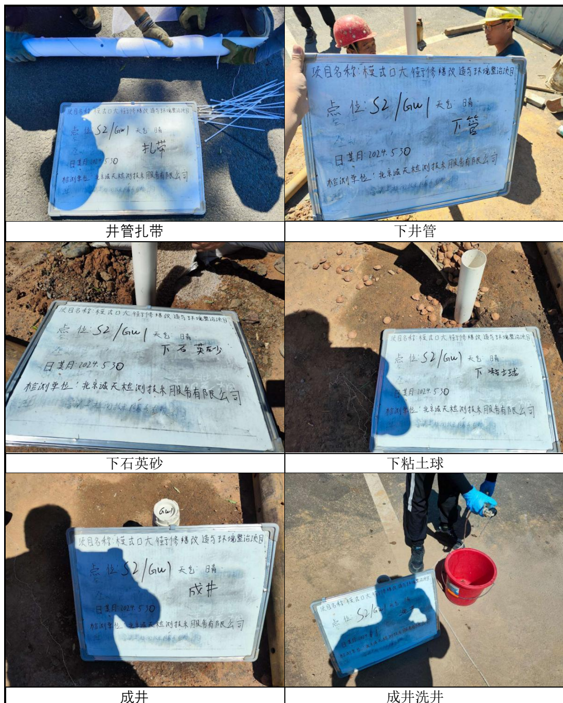
图 4.4-6 地下水监测井施工照片
